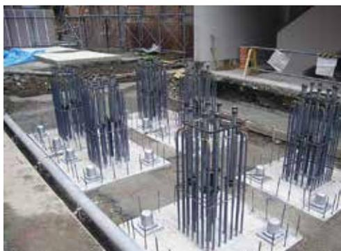
地震時や暴風時における建築構造物の転倒防止対策、地下水位の高い地盤における浮上り防止対策などを目的に開発されたアンカー工法です。
