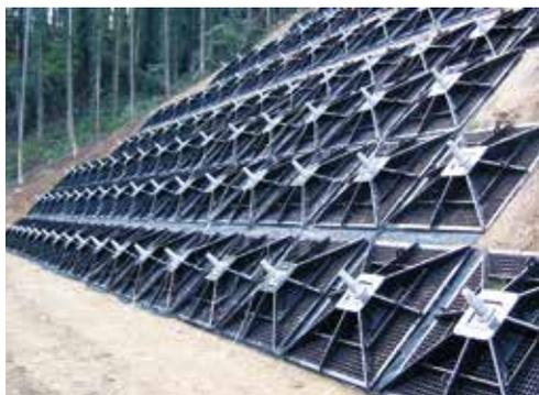
地すべり対策や斜面崩壊防止対策、構造物補強などの対策を目的に開発された高品質のアンカー工法です。付着型 ECF スtrand をテンドンに使用して、従前アンカーの複雑な構造を簡素化し、品質、経済性、施工性に優れたものとしています。
