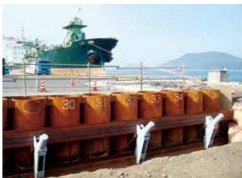
港湾・漁港構造物の地震時の滑動・転倒などの安全対策、護岸の嵩上げによる既設護岸の転倒防止などを目的に開発されたアンカー工法です。大耐力アンカーには  $\phi 12.7\text{mm}$  付着型 ECF スtrand に加え、 $\phi 15.2\text{mm}$  付着型 ECF スtrand を使用することで超大荷重の設計アンカー力  $T_d=2975\text{kN/本}$ まで適用可能です。
