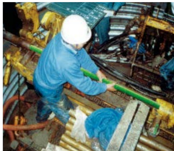
植毛暗渠パイプ挿入中
