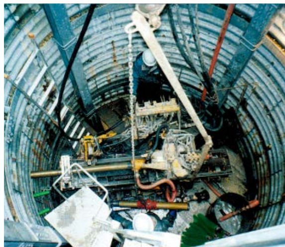
集水ボーリング工
