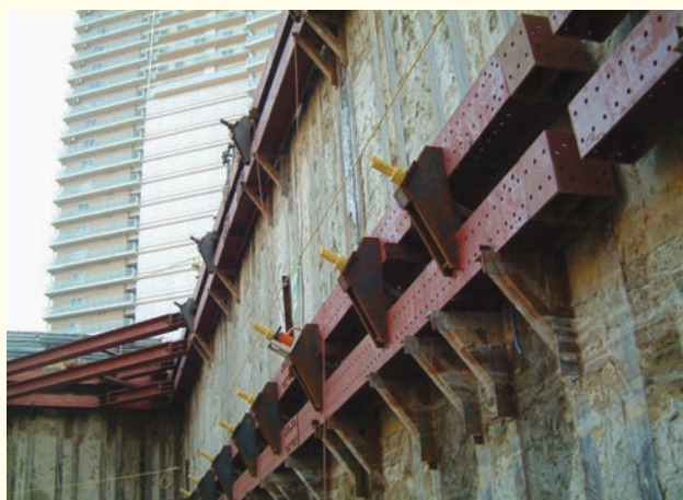
地中連続壁土留
