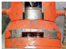
定着ジャッキ押し込み
