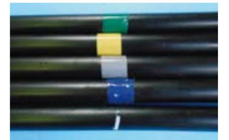
アンボンド鋼線に色をテープで示していますが、アンボンドを剥く際には、色、順番が分かるようにスプレー等で鋼線に着色するなどしてください。
