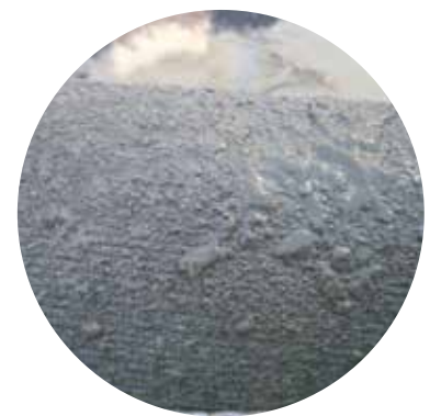
グラウト充填時のパッカー表面
