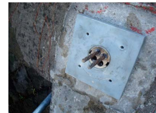
アンカーヘッド一体型支圧板による補修
