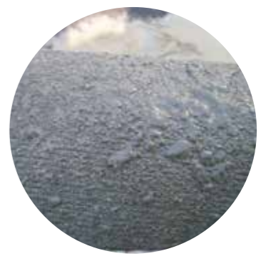
グラウト充填時のパッカー表面
