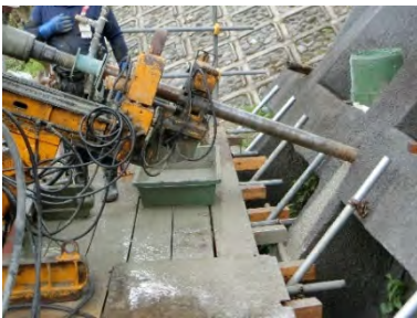
(a) 加圧注入状況
