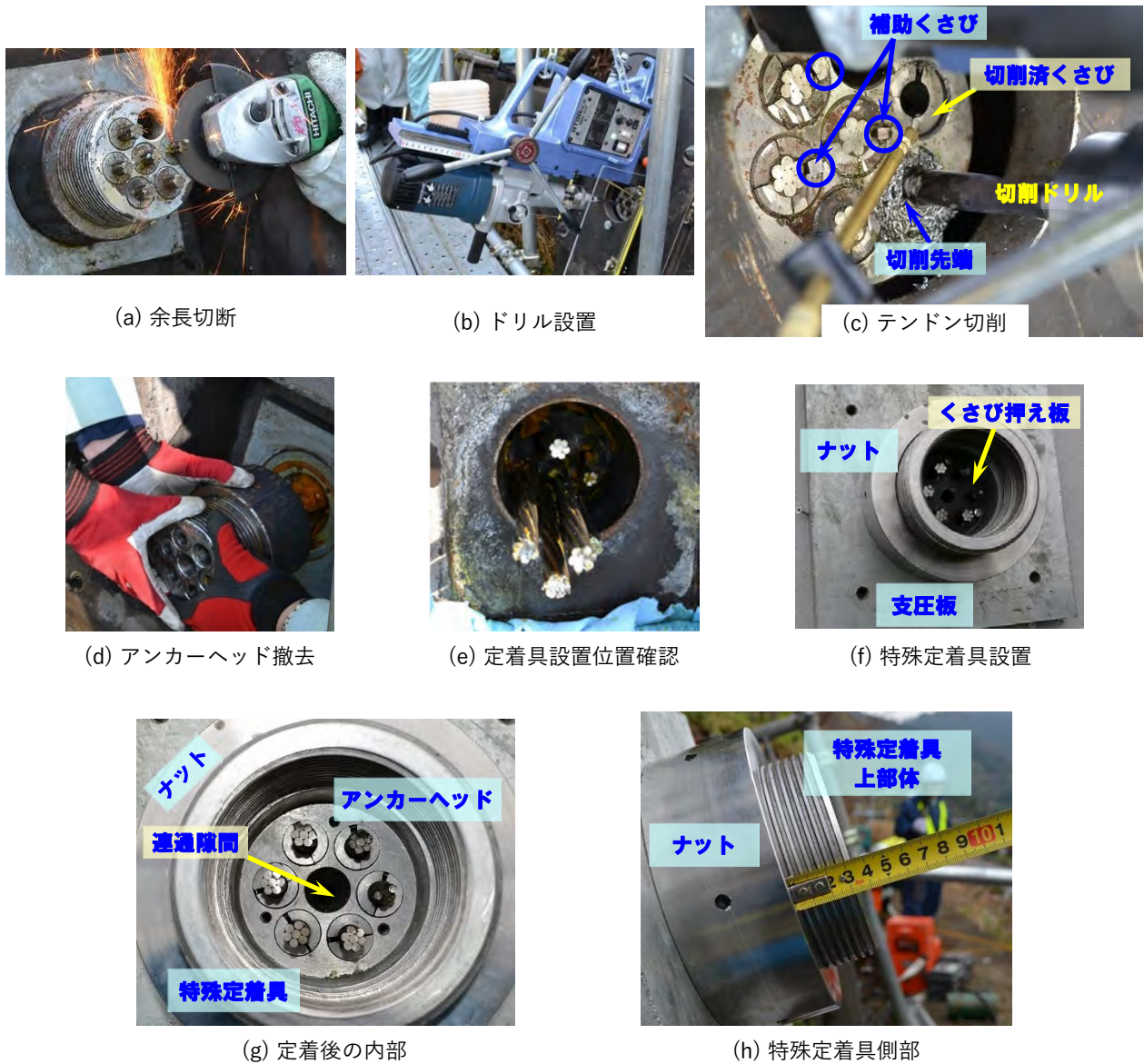
図-6.5.2 ゼロ余長除荷工法の施工手順
