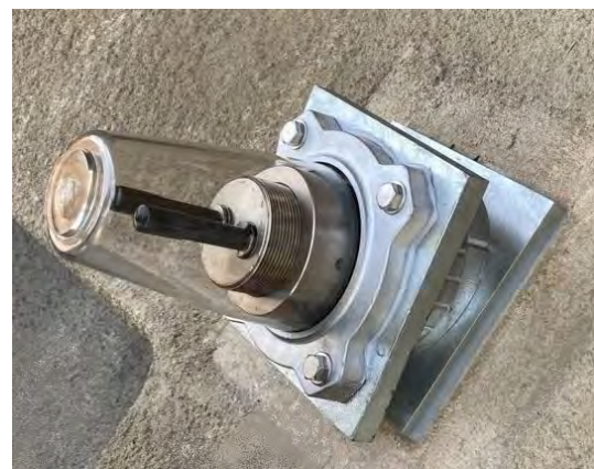
写真-5.12.1 頭部キャップ(C グレード)の設置状況
