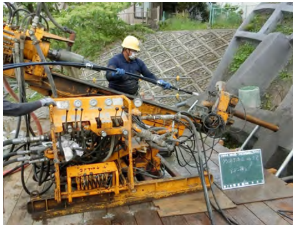
写真-5.6.1 テンドン挿入状況
