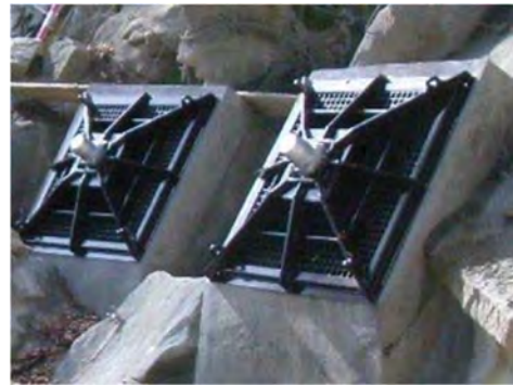
(b) 吹付後の不陸調整枠と受圧板
