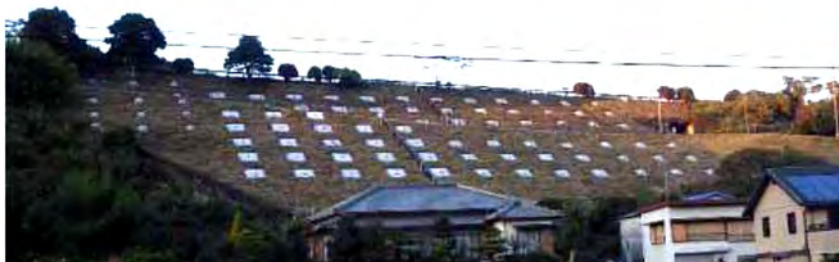
写真-4.6.1 高盛土のアンカー補強事例
