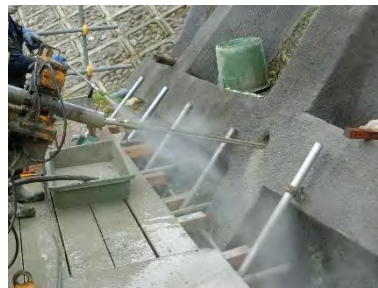
(b) 頭部洗浄状況
