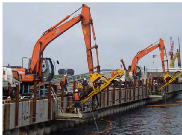
(b) 岸壁際での削孔機(アクロドリル)
