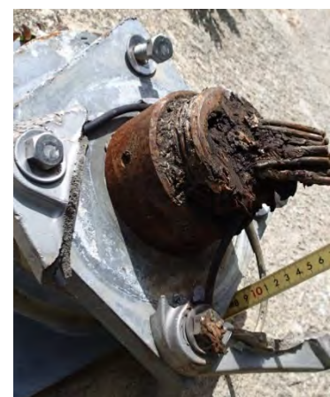
落石に伴うアルミキャップ・定着具・テンドンの破損
