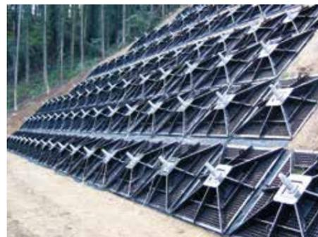
地すべり対策や斜面崩壊防止対策、構造物補強などの対策を目的に開発された高品質のアンカー工法です。付着型 ECF ストランドを tendon に使用して、従前アンカーの複雑な構造を簡素化し、品質、経済性、施工性に優れたものとしています。
