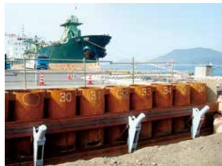
港湾・漁港構造物の地震時の滑動・転倒などの安全対策、護岸の高上げによる既設護岸の転倒防止などを目的に開発されたアンカー工法です。大耐力アンカーには  $\phi 12.7\text{mm}$  付着型 ECF ストランドに加え、 $\phi 15.2\text{mm}$  付着型 ECF ストランドを使用することで超大荷重の設計アンカー力  $T_d=2975\text{kN}$ /本まで適用可能です。
