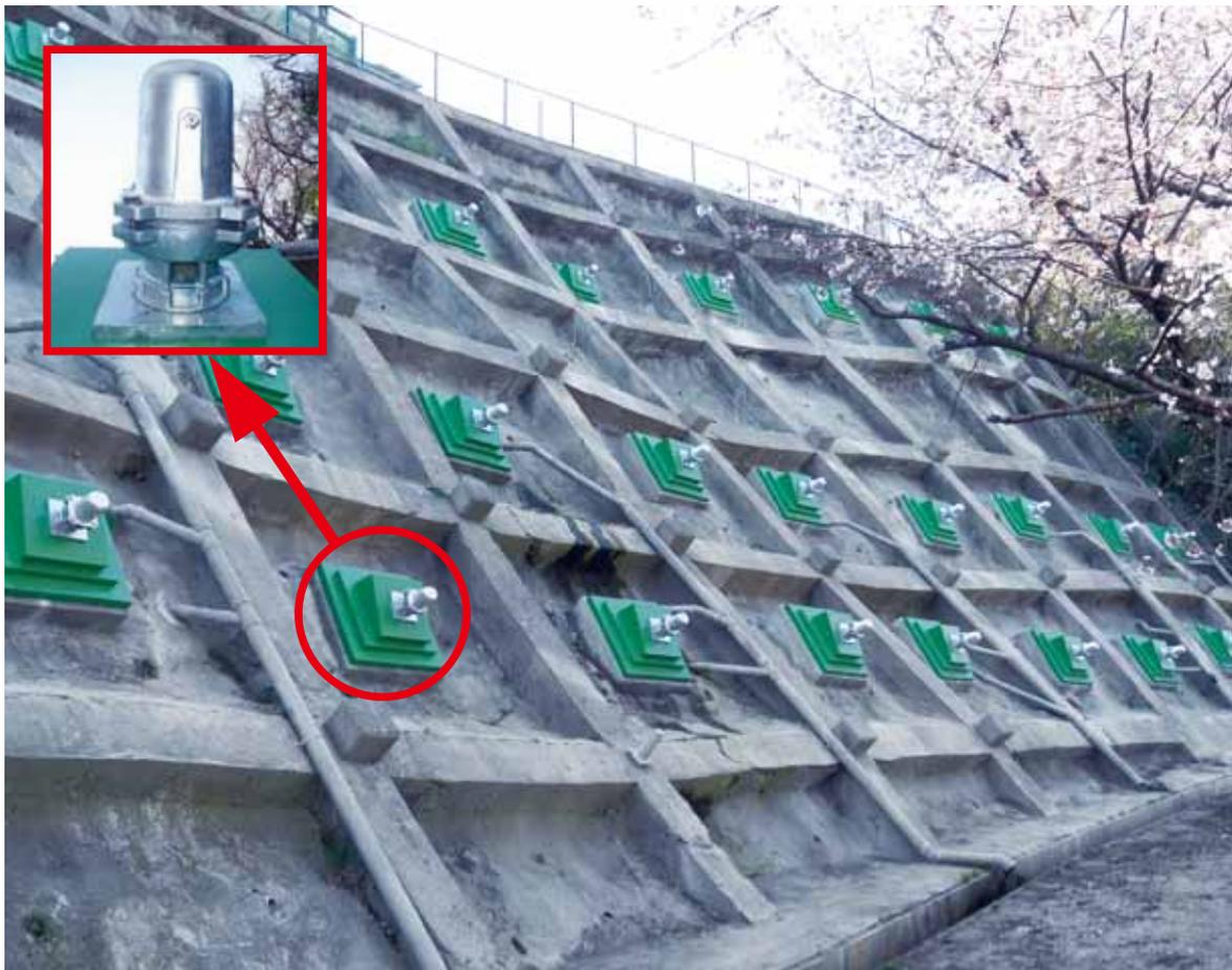
窓付止水具施工例
